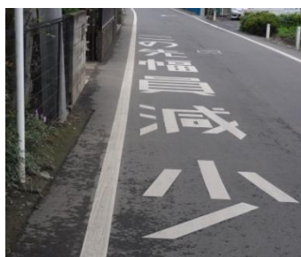
事故後、県によりグリーベルトが設置されました
