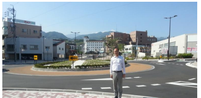
長野県飯田市の「ラウンドアバウト(信号のない円形型交差点)」 車両はこの中央の円形地帯に沿った環状の道路を一方向に通行し、それぞれの道路に流出します。環道を走行する車両に優先権があります。欧米諸国では安全でエコな交差点の制御方式として、積極的に導入されているようです。
